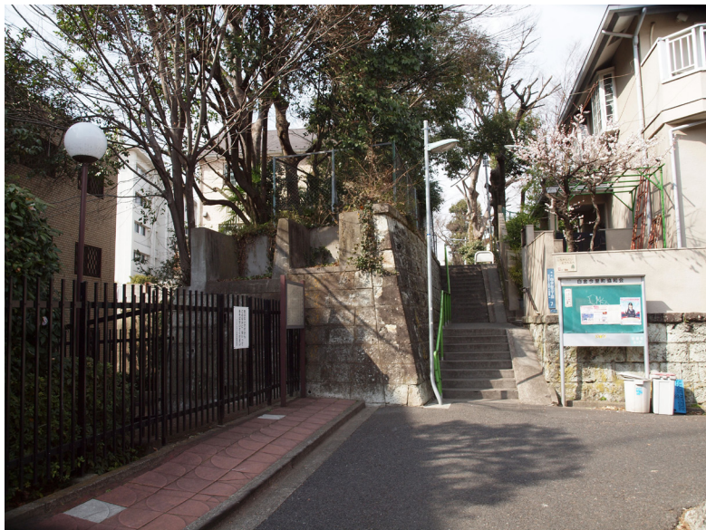
遺構番号 No.99 三田用水・白金台三丁目築樋遺構
